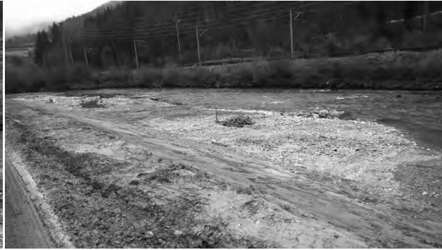
Verbreiterung der Birs mit Terrassen in unterschiedlicher Höhe
