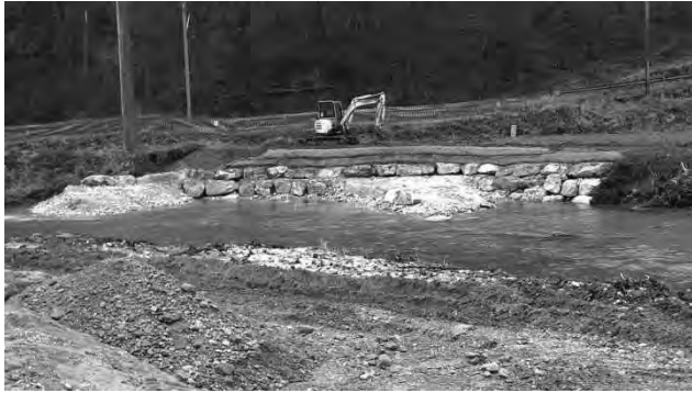
Bau der Böschungssicherung und der Bühnen beim SBB-Damm
